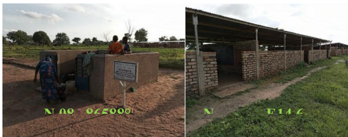
Planche 3 : pompe à motricité humaine et hangar amélioré construits par la GIZ
