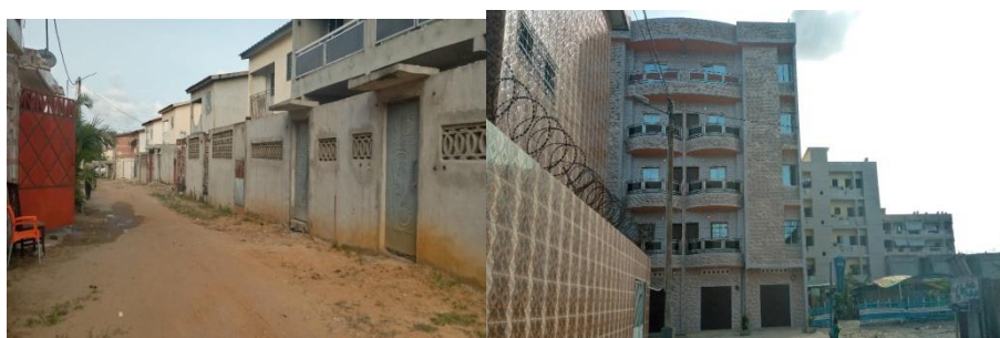
Photo 3 : Une cité du Koweït (Djoro-Djapi, 2019) Photo 4 : Des immeubles au Koweït (Djoro-Djapi, 2019)
