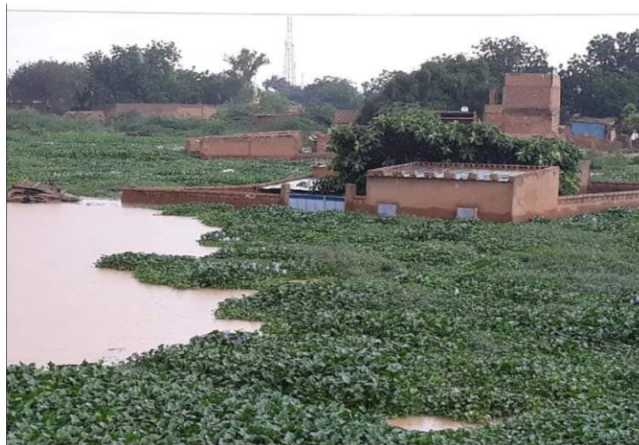
Photo n°2 : inondations à la rive droite de Niamey, avec des habitations complètement engloutis sous les eaux. Source : ADAMOU M. M, Août 2020
